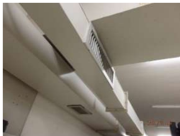
Slika 13. Ventilacijski kanal horizontalni u spremištu arhivske građe
