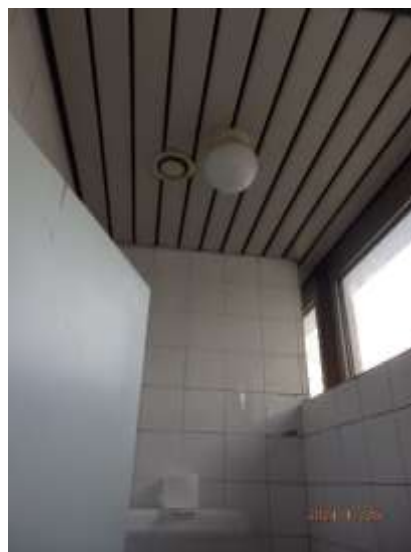
Slika 5. Ventilacijski ventil u sanitarnom prostoru
