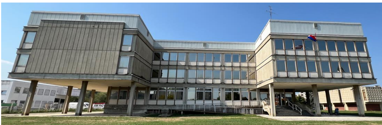
Slika 2. Predmetna građevina - jugoistočno pročelje
