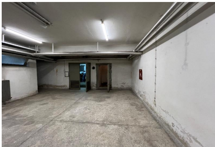
Slika 5. Nosiva konstrukcija podruma
