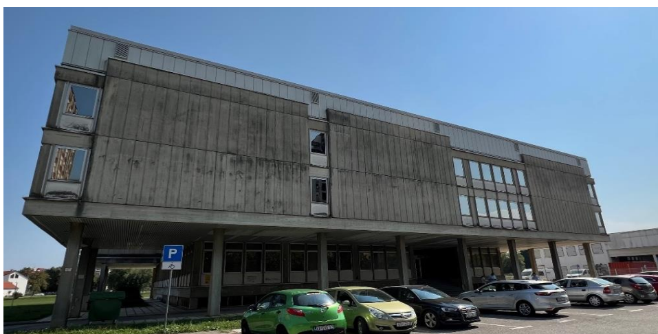
Slika 3. Predmetna građevina - sjeverozapadno pročelje
