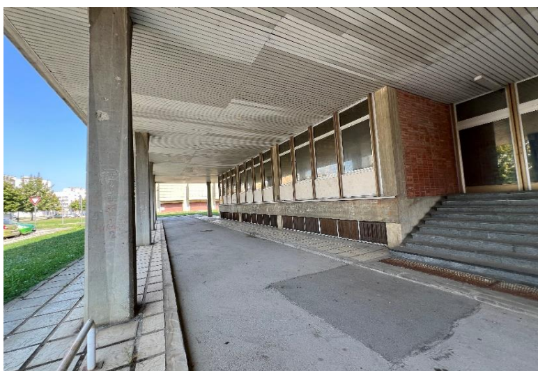
Slika 7. AB nosiva konstrukcija
