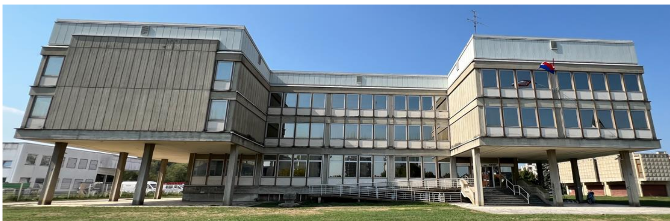
Slika 2. Predmetna građevina - jugoistočno pročelje
