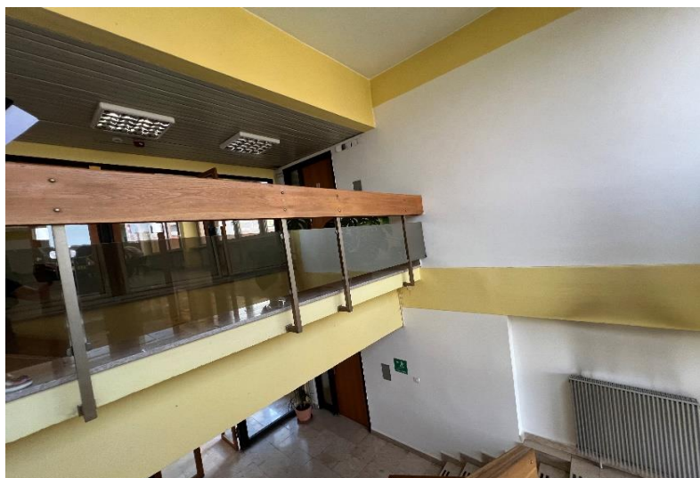
Slika 6. AB nosiva konstrukcija
