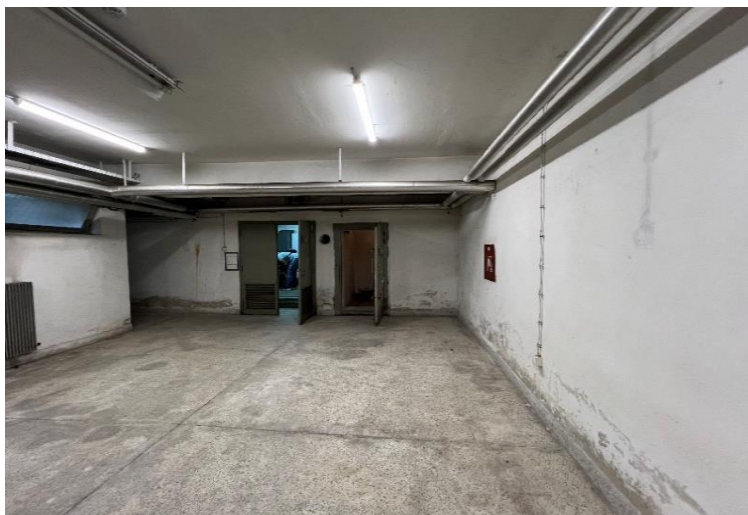
Slika 5. AB nosiva konstrukcija podruma
