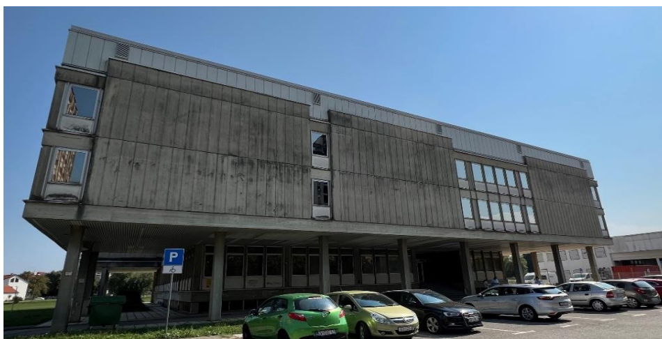
Slika 3. Predmetna građevina - sjeverozapadno pročelje
