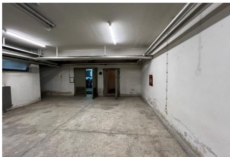
Slika 5. Skeletna AB nosiva konstrukcija
