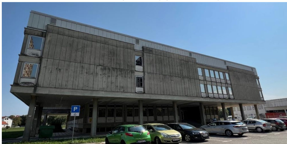
Slika 3. Predmetna građevina - sjeverozapadno pročelje
